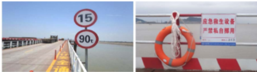
栈桥标示标牌
